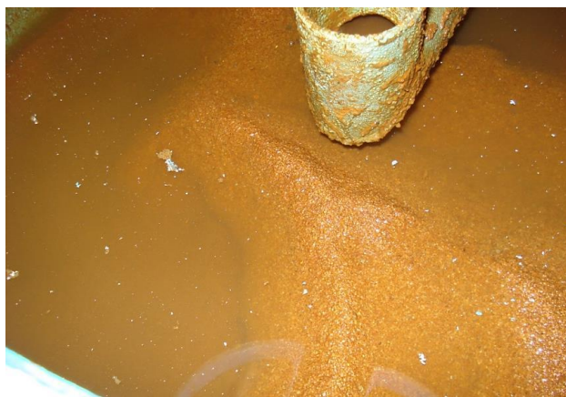
Figura 2: Detalhe da movimentação não desejada de areia no interior de um filtro operando a uma vazão elevada e fora da recomendação.
