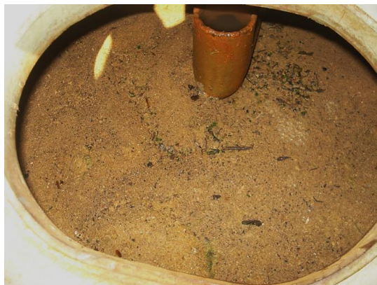
Figura 1: Detalhe de um filtro com volume excessivo de areia no seu interior.
